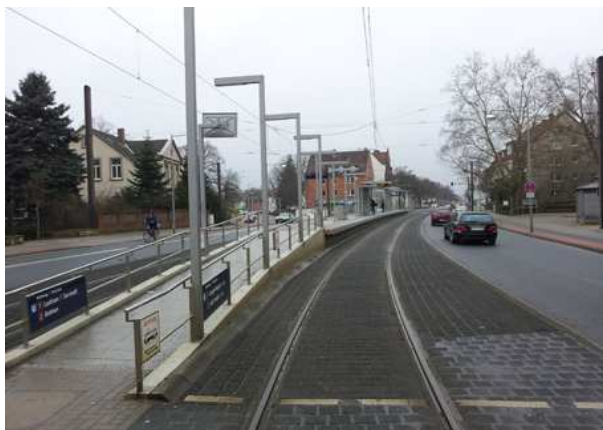
Abb. 9 Innenliegender Hochbahnsteig Hannover Foto: D.Gardemin
